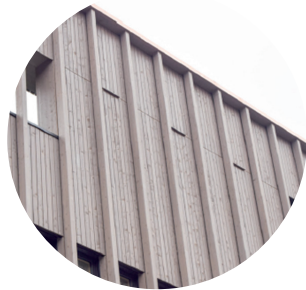
In der Fassade integrierte Fledermauskästen im neuen Rathaus der Stadt Hohenems
