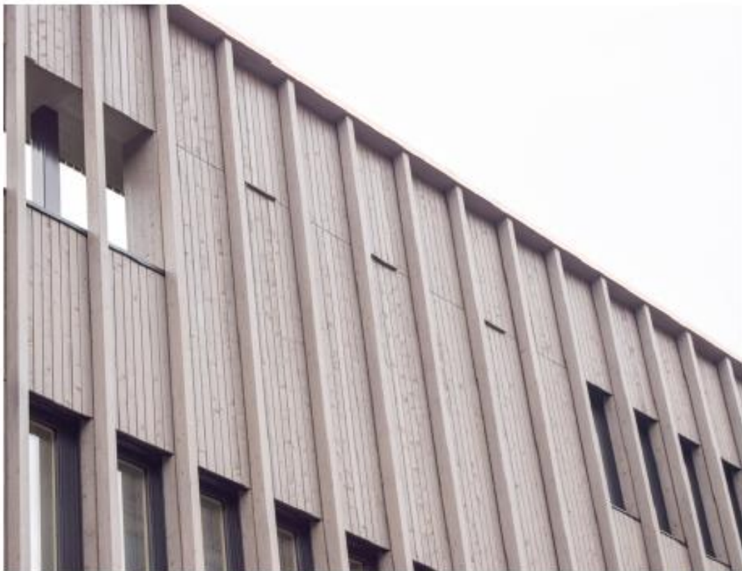
Abbildung 1: in der Fassade integrierte Fledermausnistkästen (3x) im neuen Rathaus der Stadt Hohenems (Foto von Löning)
