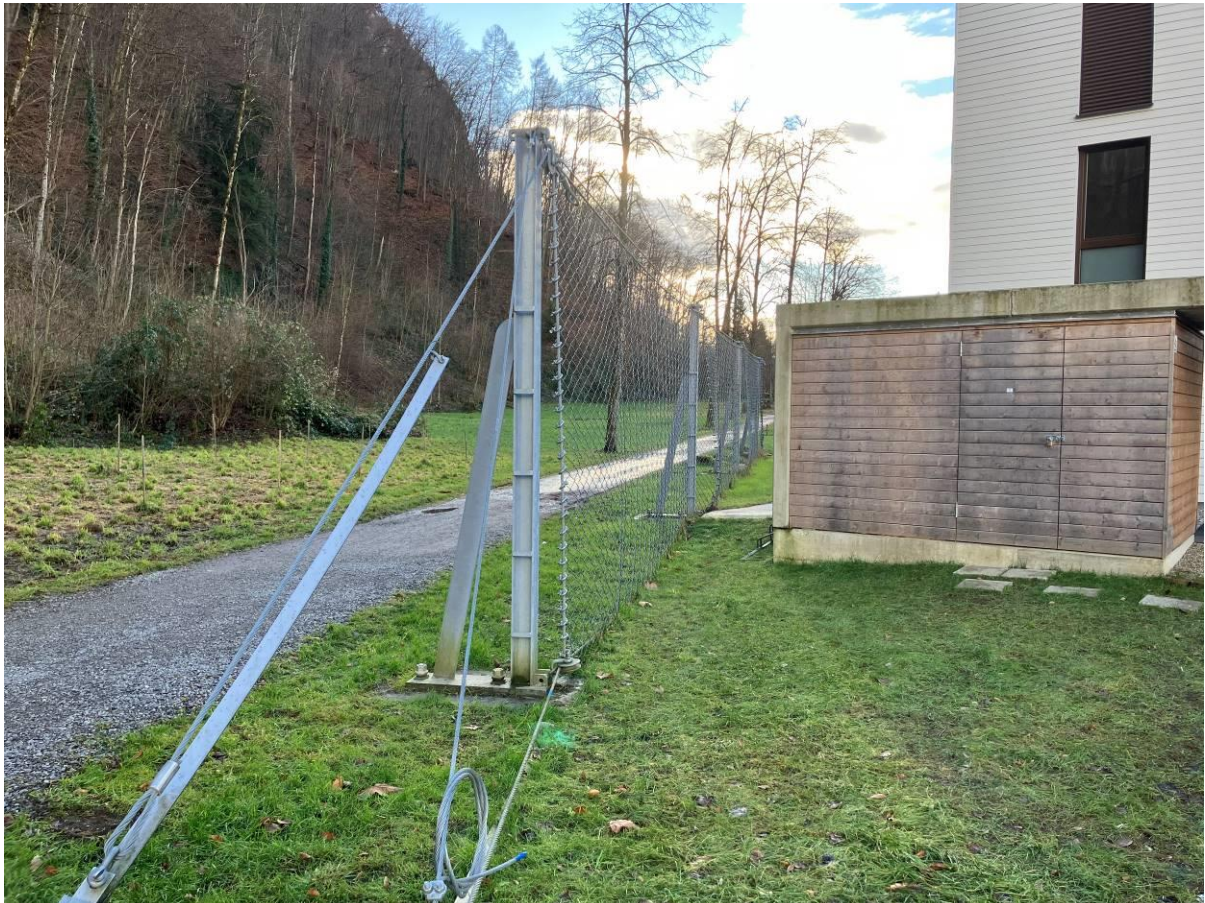
Abb. 1: Steinschlagschutznetz zum Schutz der Wohnanlage auf GST-Nr. 4447/9, KG Hohenems
