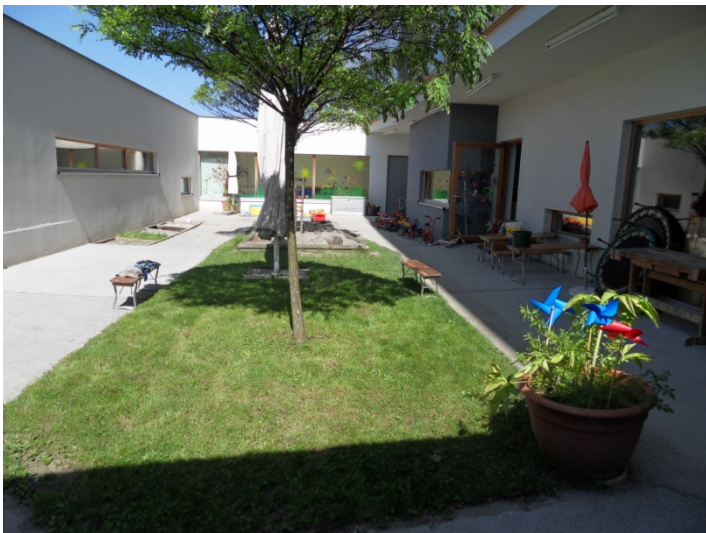
WC- und Waschbereich
